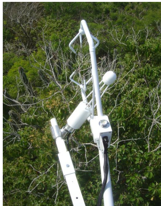
ESTACIÓN METEOROLÓGICA Y FLUJOS DE CARBONO DE LA RED TROPY-DRY
